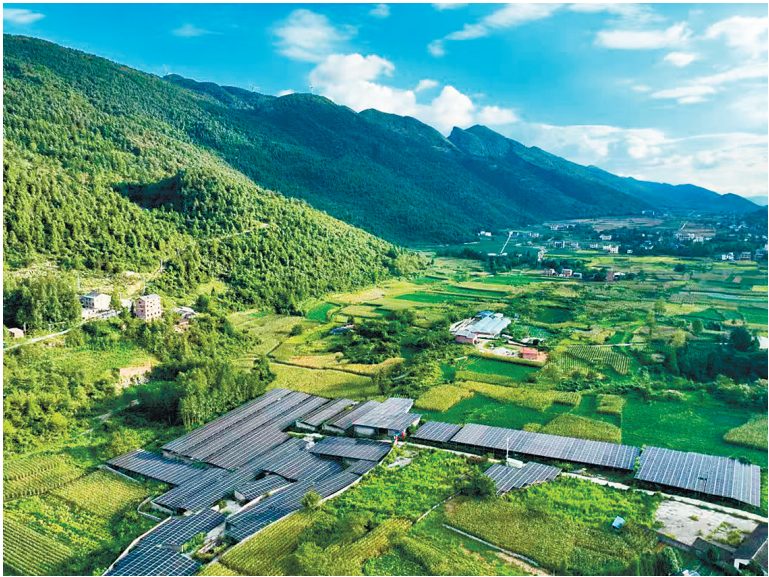
这是重庆市石柱县三星乡五斗村分布式光伏项目(2026年8月27日摄,无人机照片)。国家能源局9月1日宣布,我国光伏发电装机历史性超过煤电,成为装机规模最大的电源品类。
