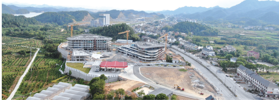
浙赣省际未来驿站项目建设现场
