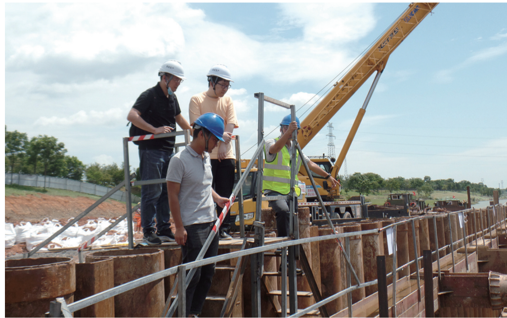
图为入保财险工作人员在在建工地现场查勘。 记者 毛瑜琼 摄
