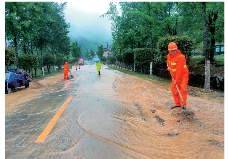
6月20日上午,公路养护人员正在开化县城白线路段忙着清除路面泥石和积水,全力保障公路安全畅通。 通讯员 徐曙光 余坚 摄
