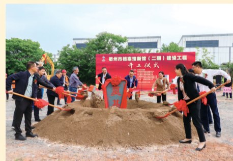
2022年5月19日,衢州市档案馆新馆(二期)建设工程开工奠基
